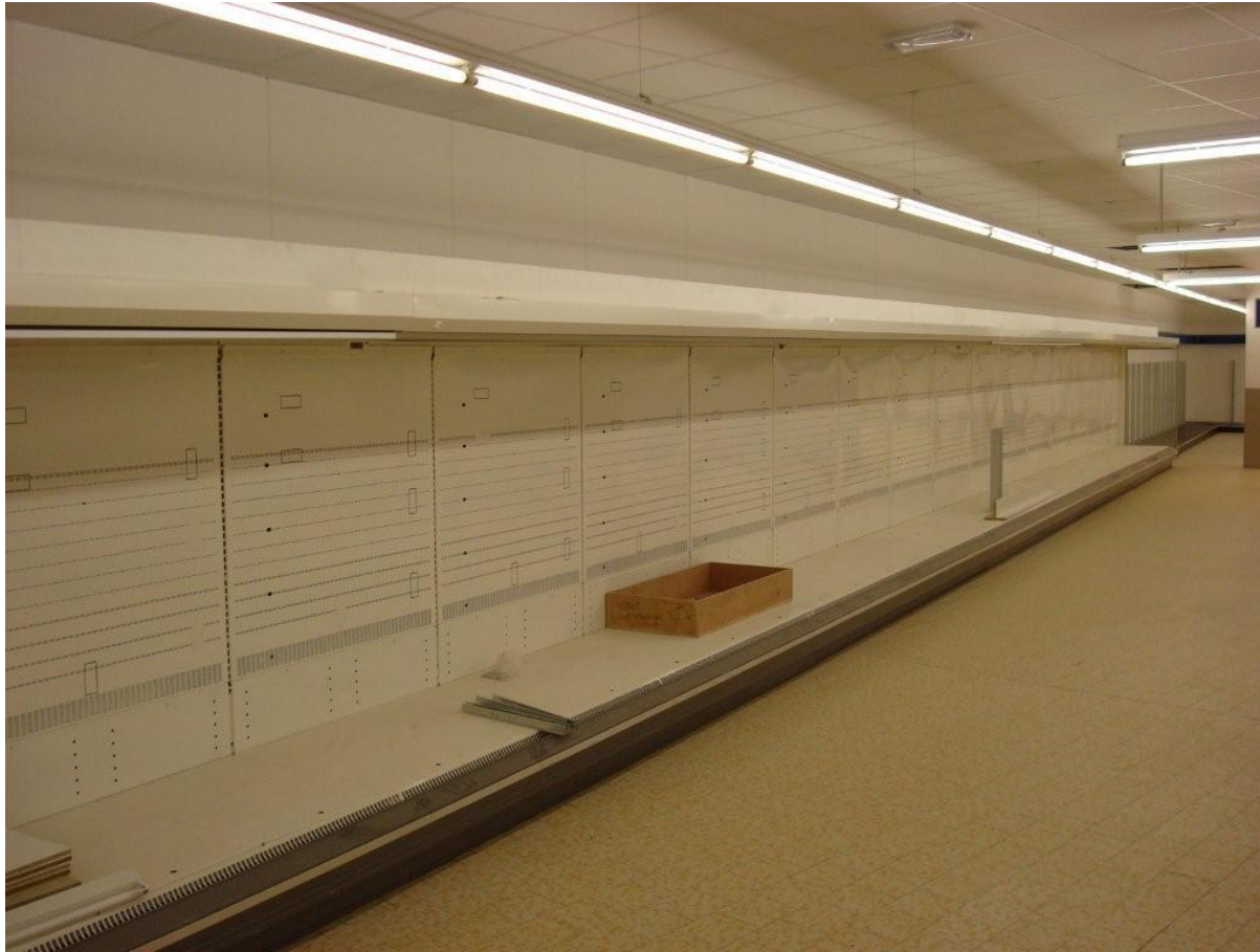
Neue MOPRO-Truhen – Montage durch Fachfirma
