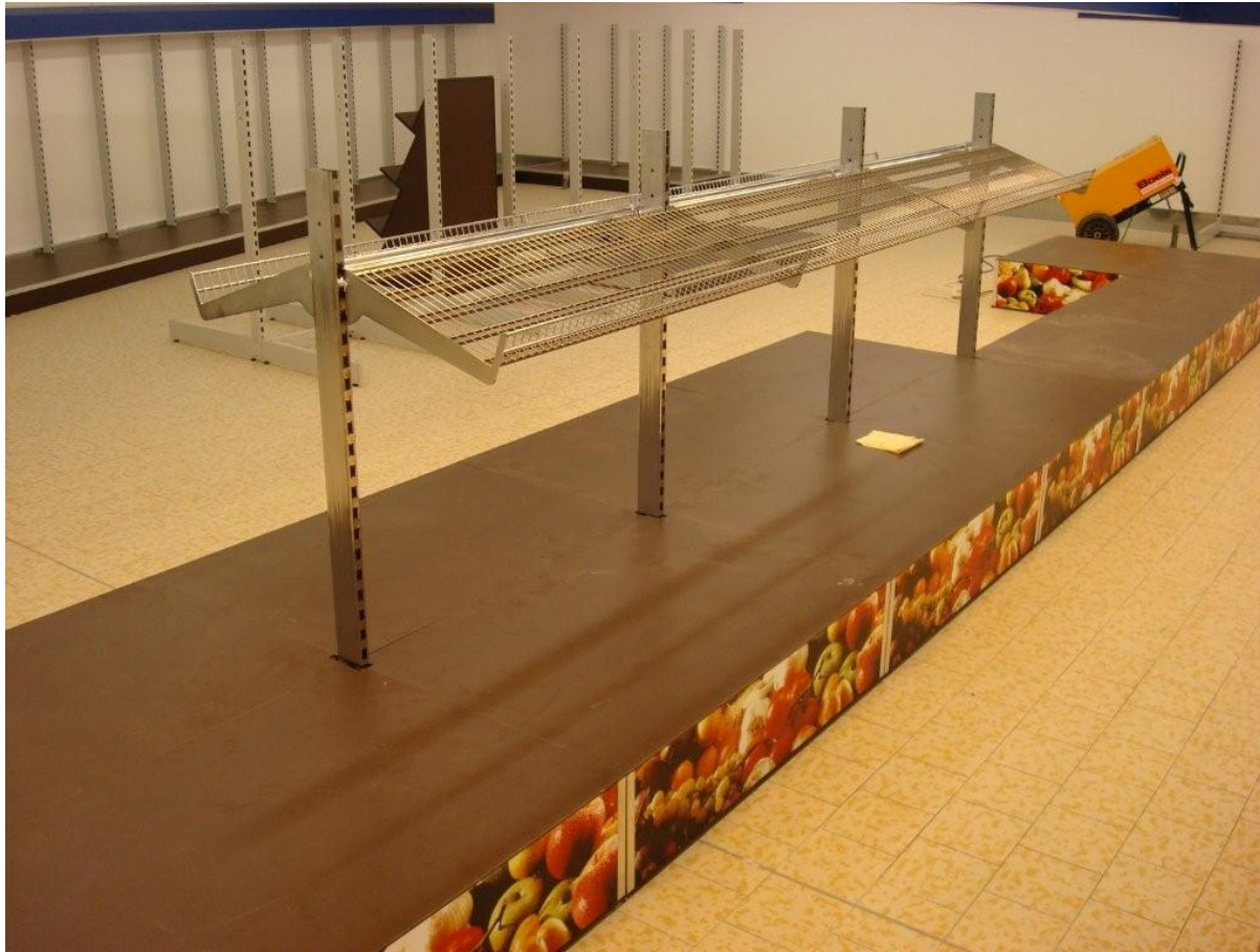
Montage Obst- Gemüse Strecke mit Überbau
