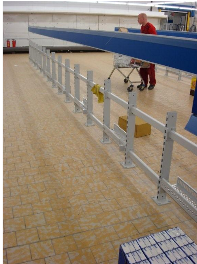
Montage TIKO Überbau
